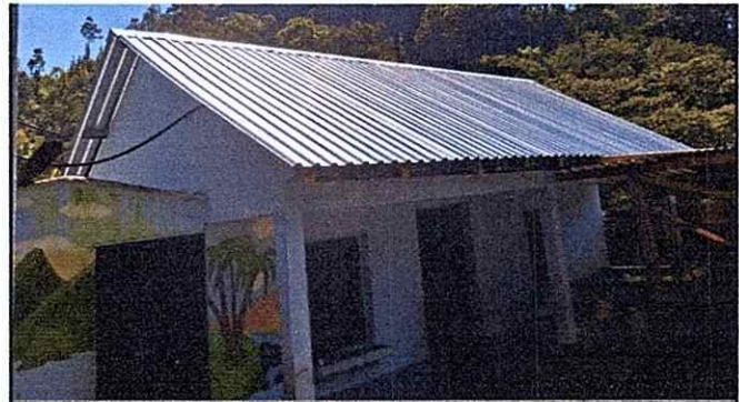
Foto 4: Cambio e instalación de cubierta de lamina troquelada para mejorar las condiciones de la cocina.
