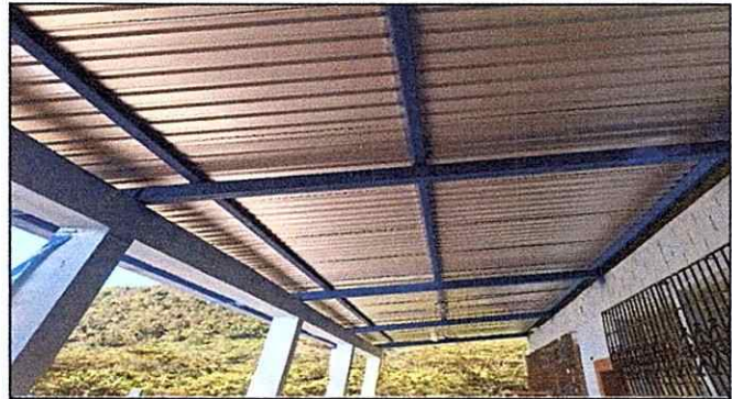
Foto 2: Mantenimiento de estructura soporte de metal (oxidación) para mayor vida útil (lijado y pintado).
