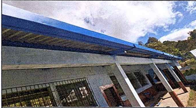
Foto 7: Instalación de canales metalicos con sus respectivos pescantes para mejorar la captacion de aguas pluviales.
