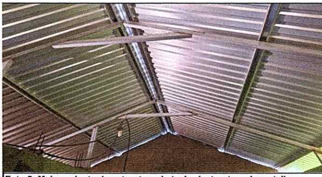
Foto 5: Mejoramiento de estructura de techo (estructura de metal) para mayor durabilidad.
