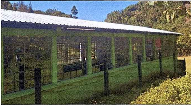
Foto 1: Instalación de lamina troquelada para mejorar las condiciones actuales el ambiente (AULAS).
