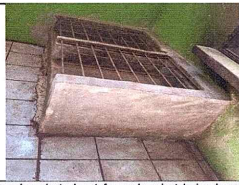
Foto 6: mejoramiento de estufas rurales e instalación de parrillas metálicas.
