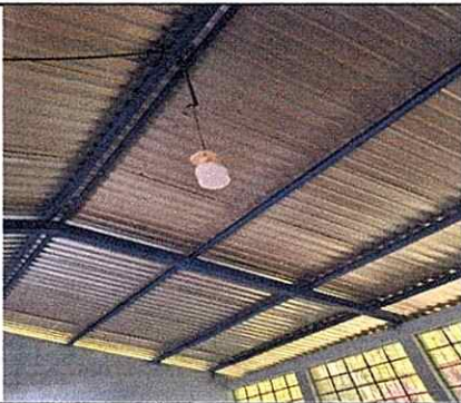
Foto 3: Mantenimiento de estructura soporte de metal (oxidación) para mayor vida útil (lijado y pintado).
