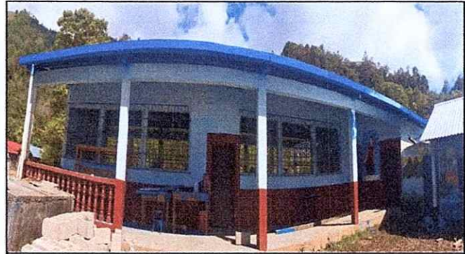
Foto 8: Instalación de canales metalicos con sus respectivos pescantes para mejorar la captacion de aguas pluviales.
